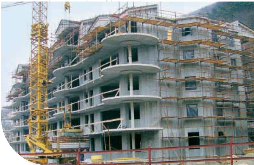
BAUSTELLE APARTEMENT KRISTOFF PLAZA, TRENČIANSKE TEPLICE
