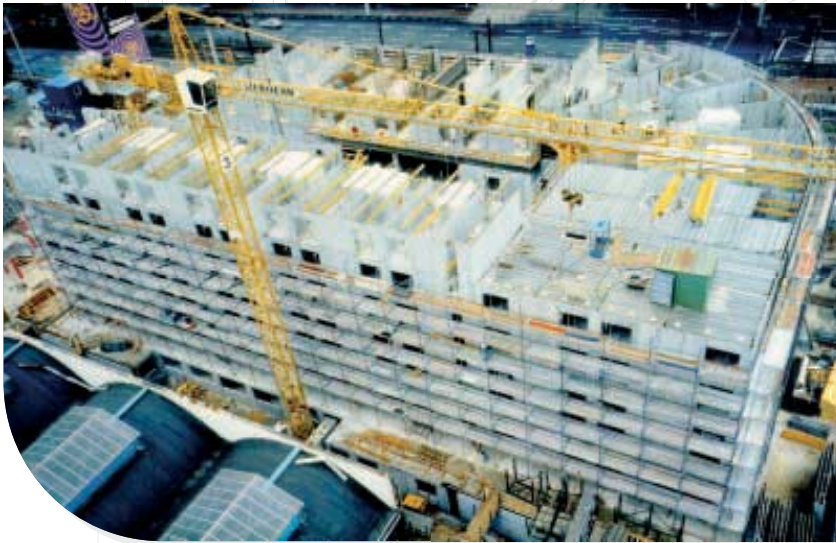
BAUSTELLE DORINT HOTEL AN DER MESSE KÖLN-DEUTZ
